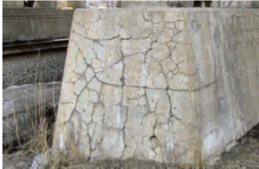
図-1 ASR により発生する亀甲状ひび割れ [1]
