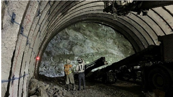
切羽写真の投影による吹付け前の切羽の再現
