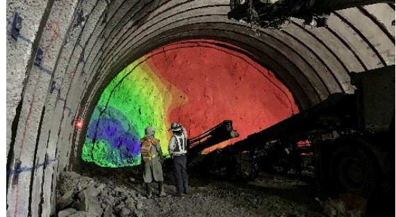
岩盤の硬軟分布を示すカラーカウンター図の投影状況
