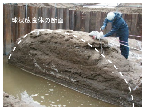
試験施工で確認した注入改良体
