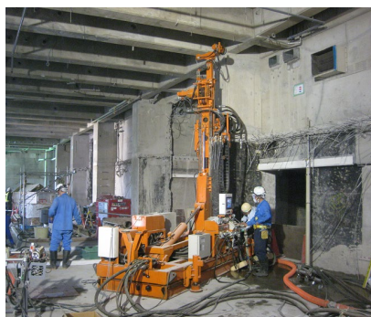
既設建物内での施工 (φ 800mm、最大長さ 8m、計 8 本を施工)
