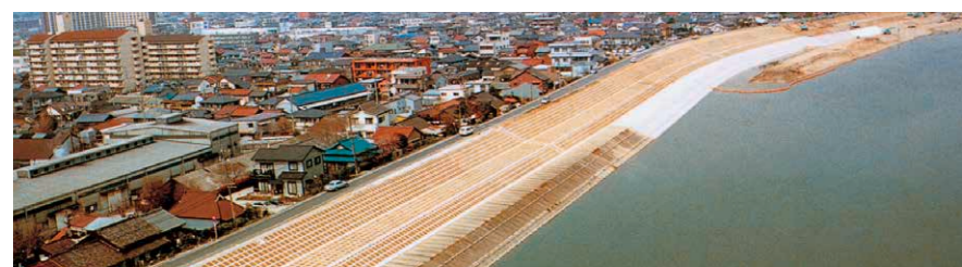
一級河川庄内川十軒裏護岸災害復旧工事 [愛知県]
