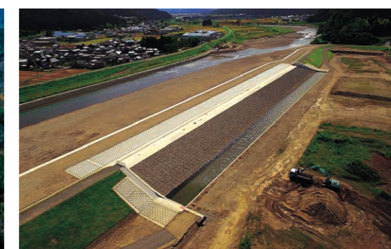
一級河川五十嵐川災害復旧助成事業 団繞堤(その2)・越流堤工事 [新潟県]
