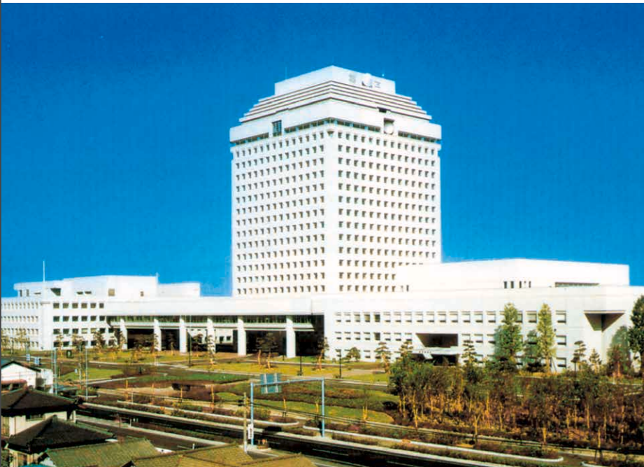
新潟県議会庁舎議会議棟：第1回公共建築賞「優秀賞」受賞【新潟県】
