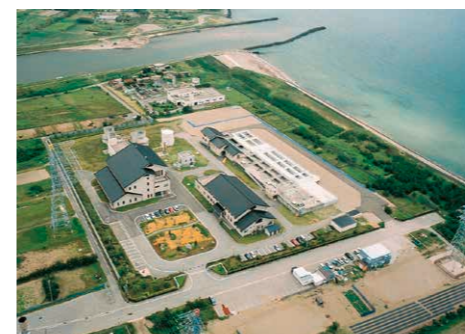
国府川処理場水処理施設土木工事 [新潟県]
