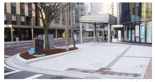
古町歩道その3工事 [新潟県]
