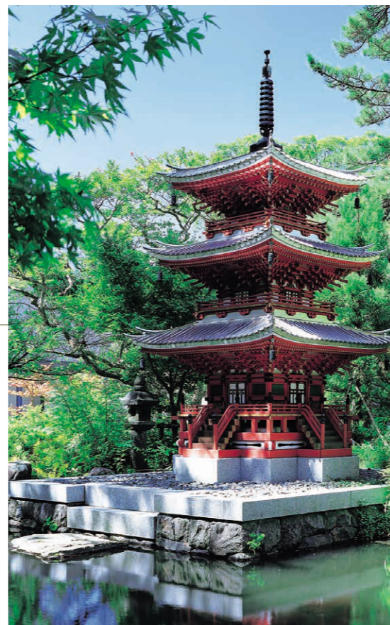
角田山妙光寺三重塔修復(国登録有形文化財) [新潟県]
