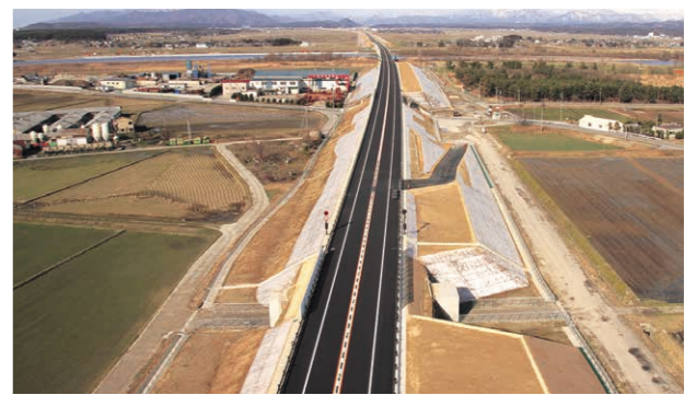
日本海沿岸東北自動車道 荒川舗装その2工事 [新潟県]
