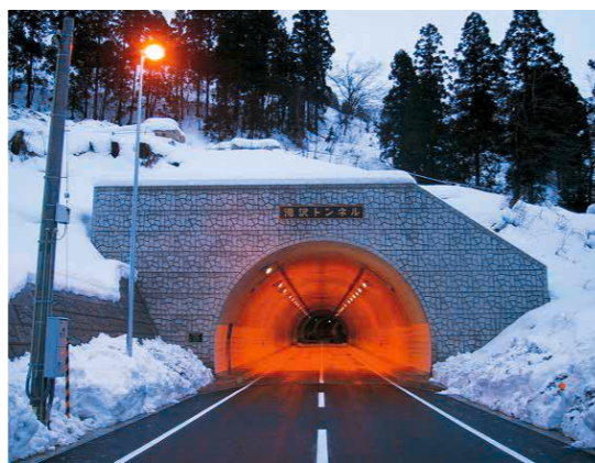
濁沢トンネル [新潟県]
