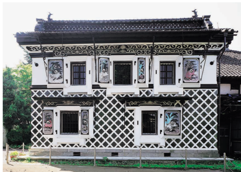
機那サフラン酒製造本舗土蔵(国登録有形文化財) [新潟県]
