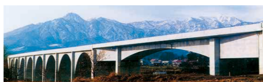
上信越自動車道 万内高架橋工事 [新潟県]
