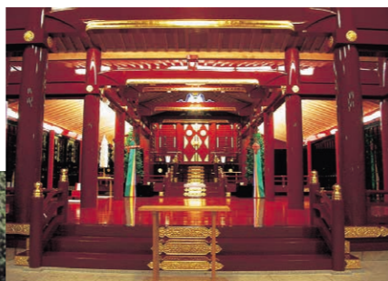
新潟縣護國神社(神殿改修) [新潟県]
