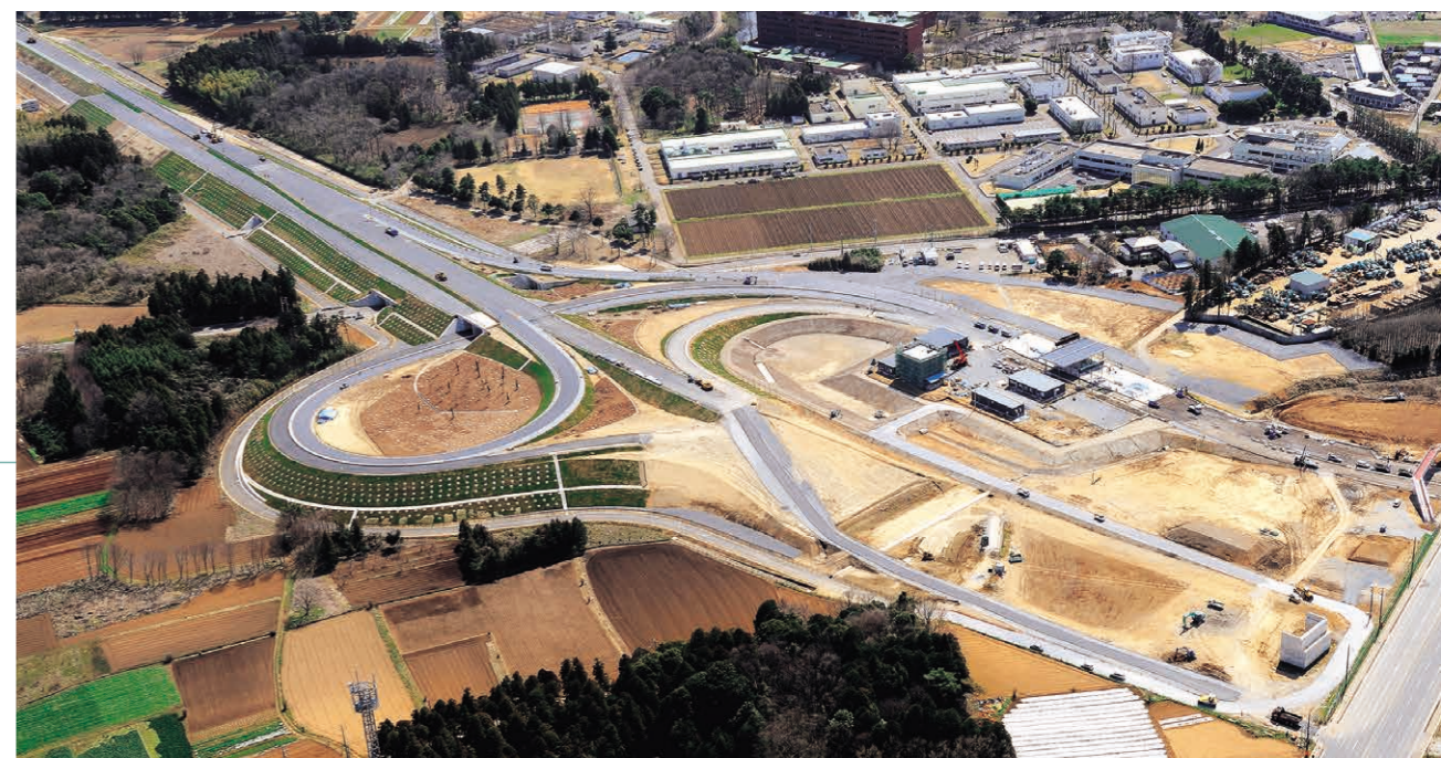
圏央道 つくば IC 改良その4工事 [茨城県]
