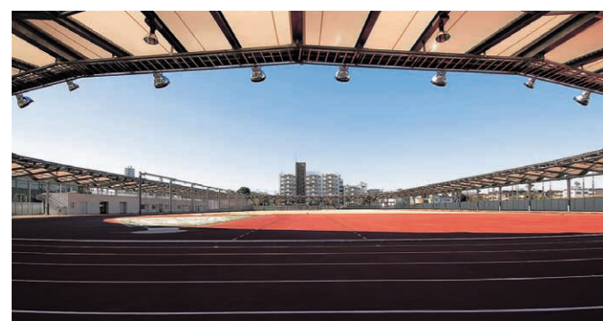
ナショナルトレーニングセンター(屋外トレーニング施設) [東京都]
