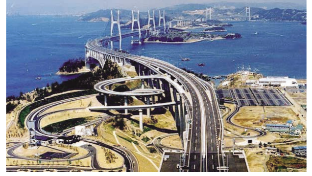
本州四国連絡橋 (瀬戸大橋) 共用部南舗装工事 [香川県]
