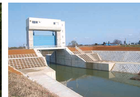
五社川水門 改築工事 [新潟県]
