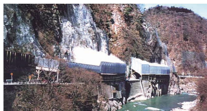
綾戸防災その3工事 [群馬県]
