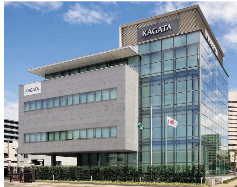
加賀田組本社社屋【新潟県】
