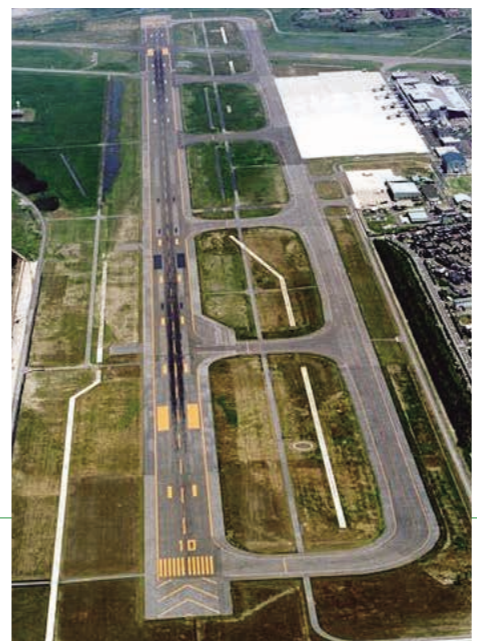
新潟空港エプロン・滑走路新設工事 [新潟県]
