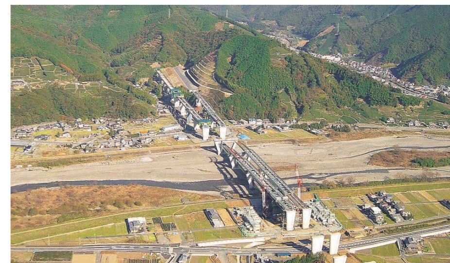
第二東名高速道路薬科川橋東(下部工)工事 [静岡県]
