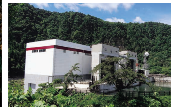
鹿瀬発電所改修工事のうち土木本工事 [新潟県]
