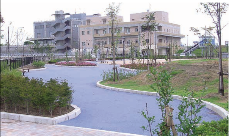
親松排水機場敷地内整備 [新潟県]
