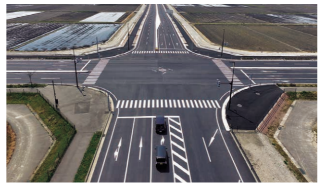
主要地方道新潟中央環状線横越バイパス [第1工区] 舗装 (その1) 工事 [新潟県]
