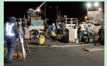
レベルによる舗装面監視
