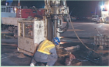
削孔スライムもすべて回収
