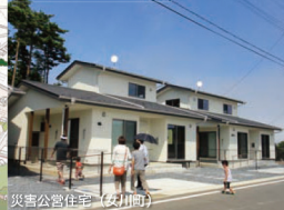
災害公営住宅（安川町）
